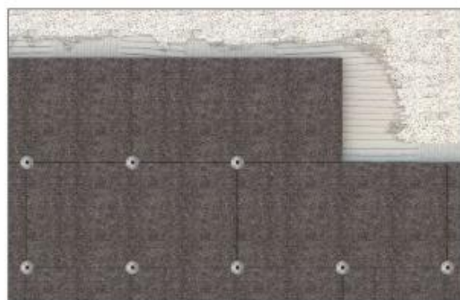
ファスニング施工位置例
